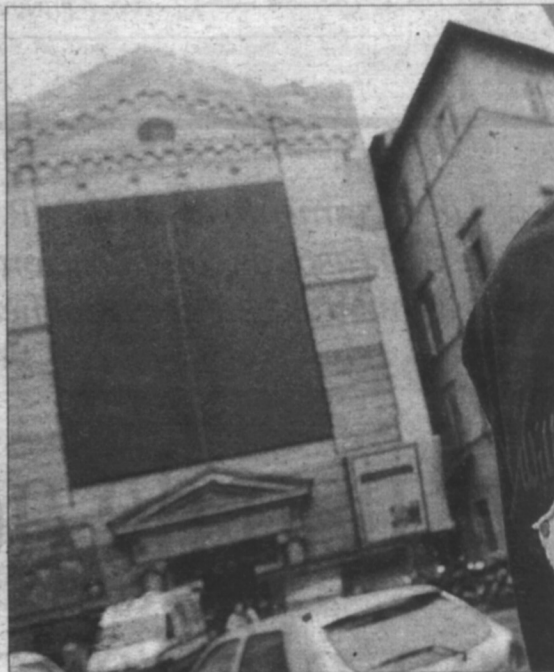
DESPUÉS. Cartel cubierto por una lona.
